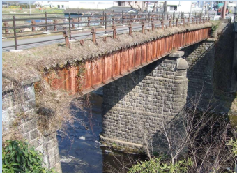
明治橋外観(上流側から)
